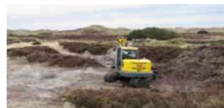
Baggerarbeiten Mitte März in den Dünen bei Wittdün auf Amrum
