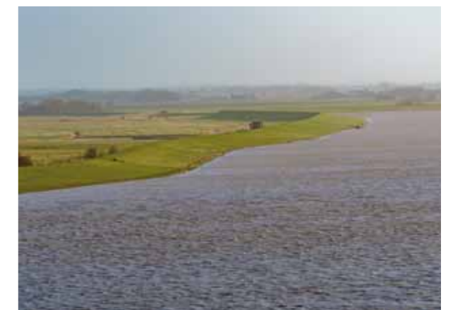
Beim Blick von oben auf den Seedeich ist klar zu sehen, wie hoch das Wasser über dem Binnenland steht. Das Bauwerk am Deich ist das Schöpfwerk, das auch bei normalem Wetter das Regenwasser aus der Marsch hoch ins Watt pumpt.
