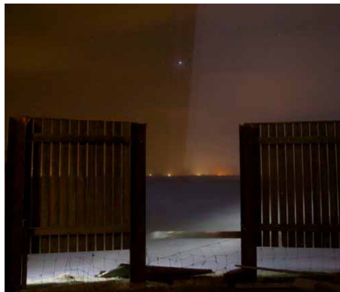
Im Südwesten des Windschutzzauns ist ein Element heraus gebrochen.
