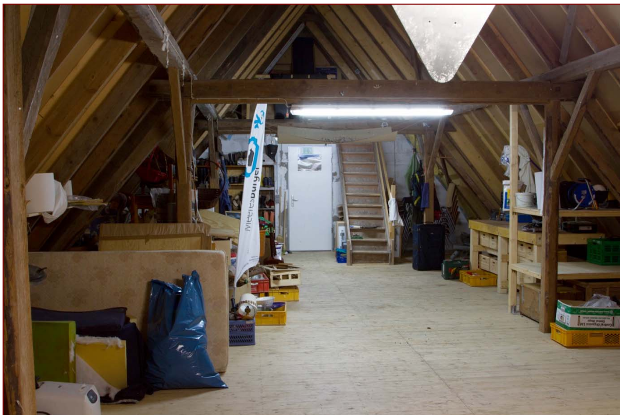
Abbildung 3: Innenansicht des derzeitigen Dachbodens – Perspektive I
