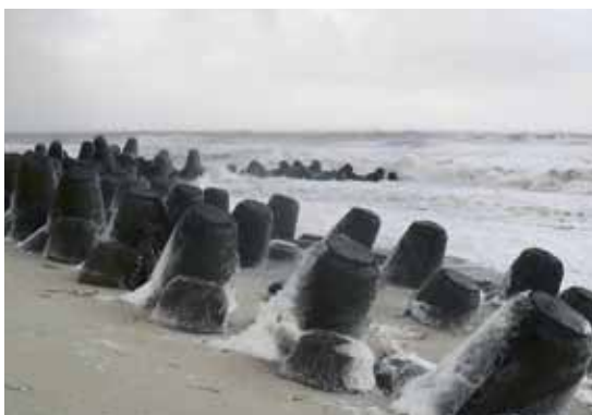
Tetrapodenreihe mit in die Brandung ragendem Querwerk
