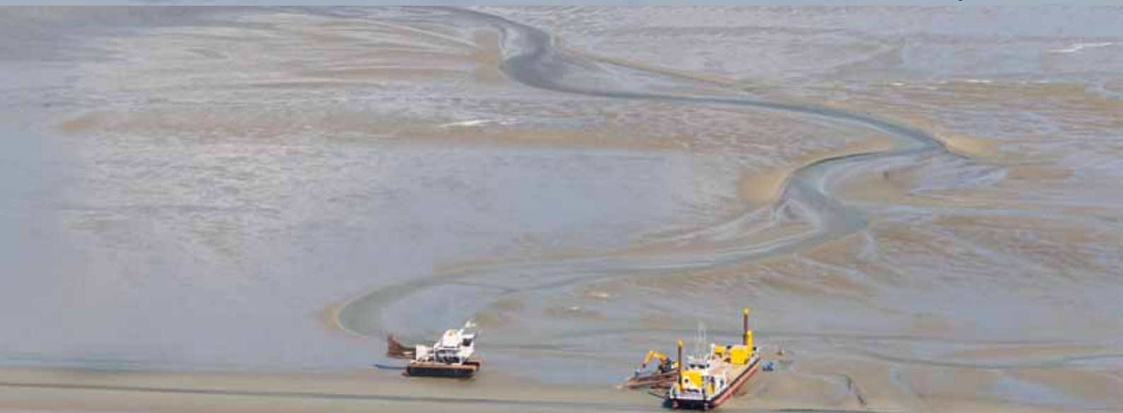
Eine Kabelfräse am 26. Juli bei der Vorbereitung der NordLink-Kabeltrasse auf den Wattflächen bei Büsum (© GFN).
